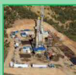
Equipos de perforación en una zona donde ya se han llevado a cabo 10 pozos. © tedx
